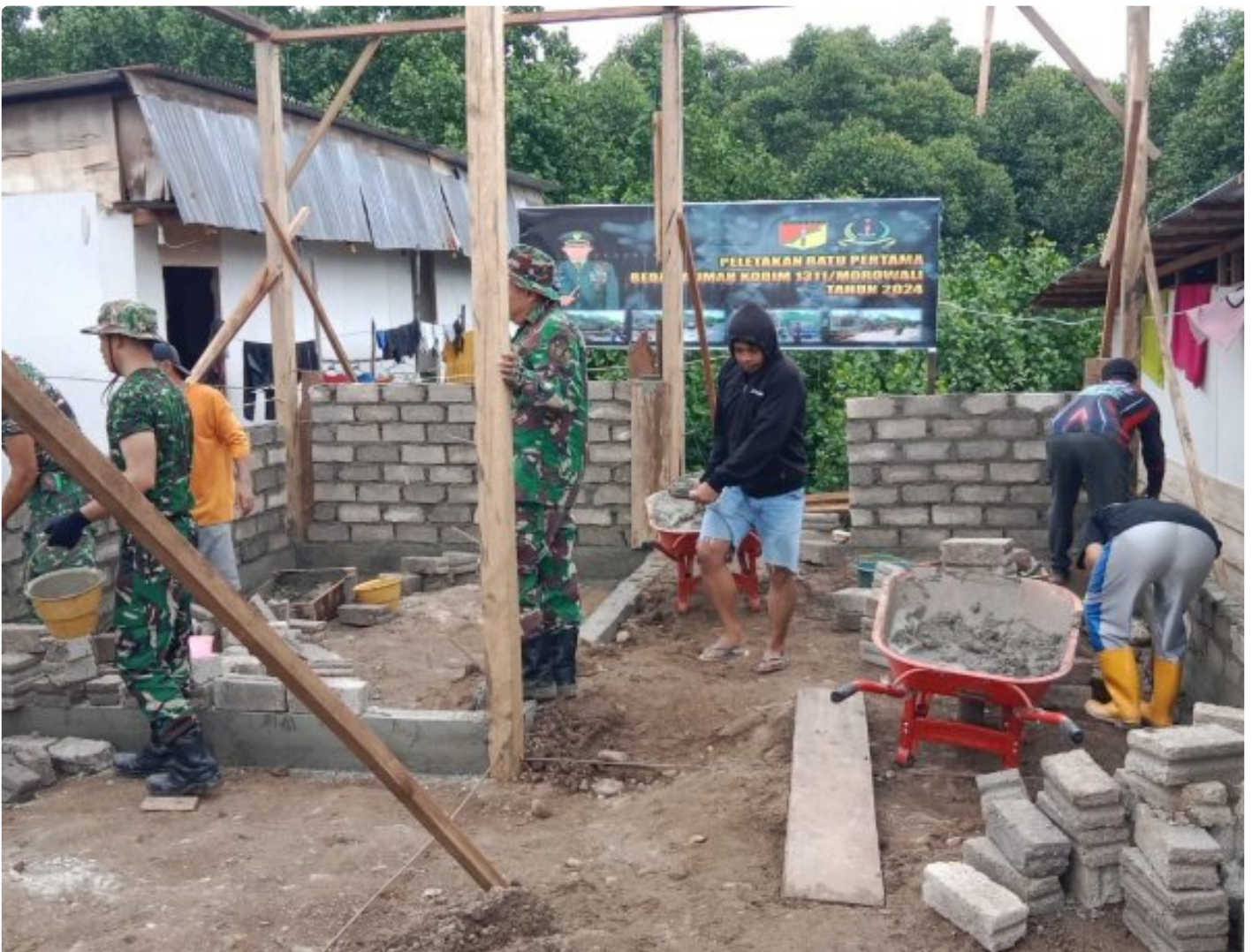
Tampak pengerjaan bedah rumah tahap pemasangan Batako
