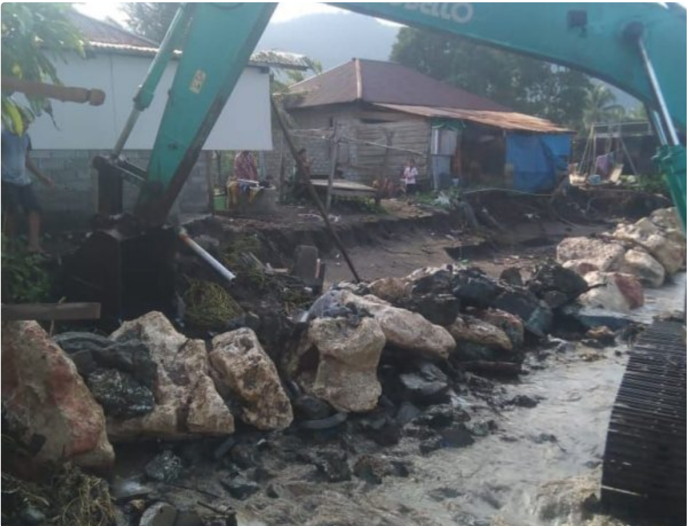
Proyek pemecah ombak di desa kolono
